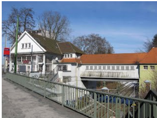
Rellinghauser Straße 175 (mit Übergang über der S-Bahn, gegenwärtig geschlossen; denkmalgeschütztes Gebäude; mehr dazu hier )
